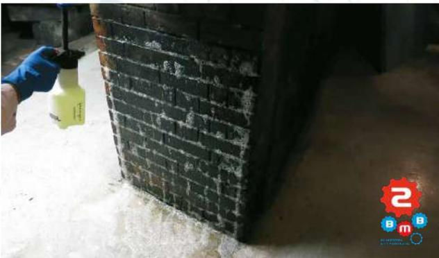
Die derart vorbehandelten Materialien werden mit dem zweiten Produkt (BMB 2) mehrmals besprüht. Bei dieser Vorbehandlung kann die Flüssigkeit durch die gesamte Putzschicht eindringen und somit kann eine umfassende Benetzung aller Mikroorganismen erreicht werden. Zusätzlich kommt es in diesem Verfahren zu einer optischen Indikation der Fremdfarbstoffe. Algen werden in diesem Verfahrensschritt umfassend vorgeschädigt.
